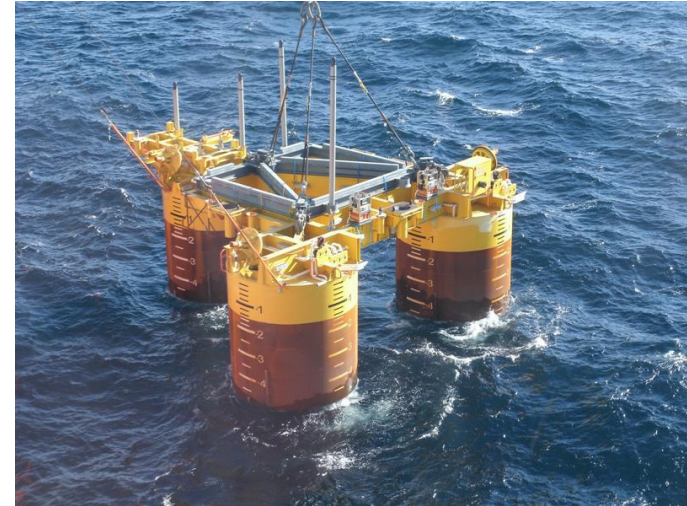
Installasjon av undervannsstruktur
