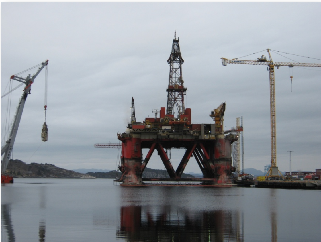
Store kraner benyttes fra flere hold for å kunne arbeide effektivt. Legg merke til personellheisen like til høyre for riggen. Bildet er gjengitt med tillatelse fra Coast Central Base AS.
